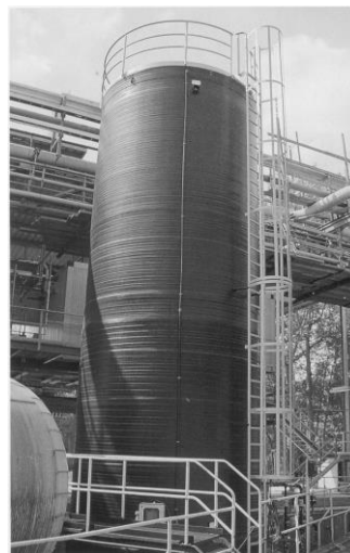
zbiornik dwupłaszczowy z PEHD, V=50m³
