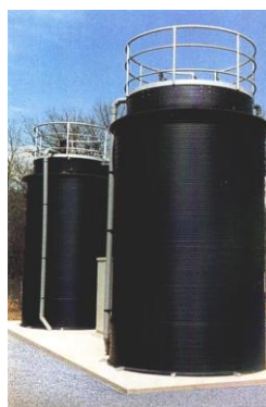
zbiornik jednopłaszczyzowy z dodatkowym zbiornikiem ochronnym, V=25\text{m}^3
